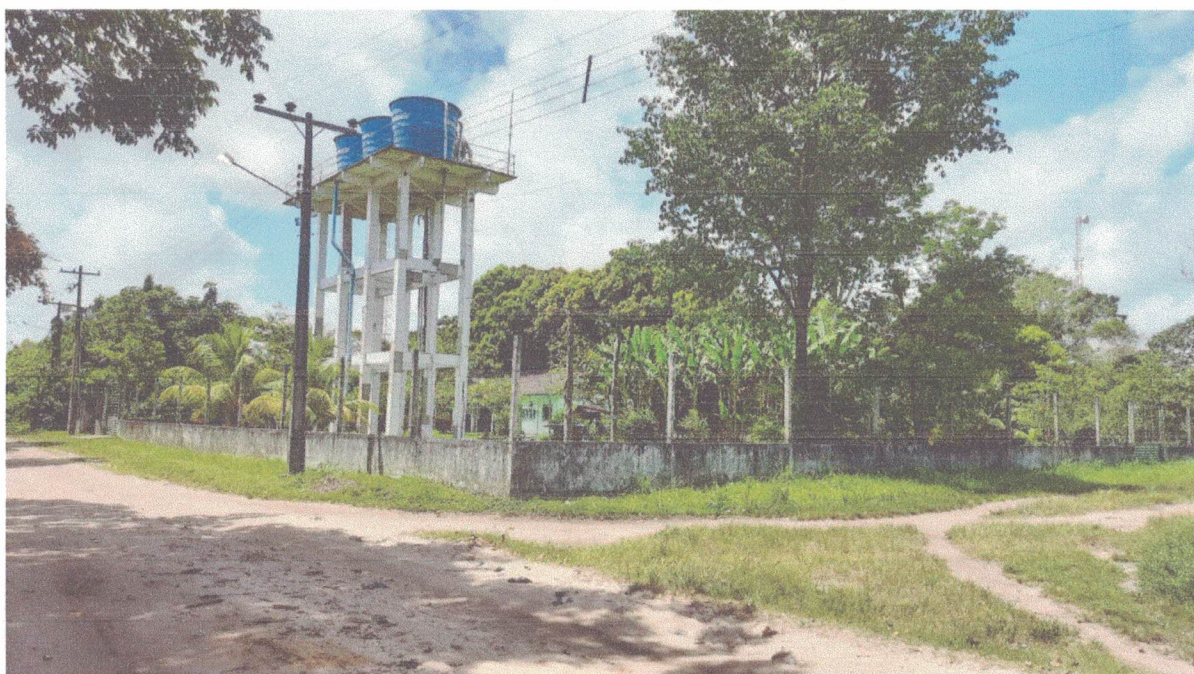
FOTO 01. Sistema de captação e distribuição do Marapira – POÇO DE JACÓ, 2021.
