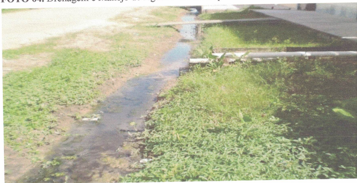
FOTO 04. Drenagem e Manejo de Águas Pluviais Improvisadas, 2013
